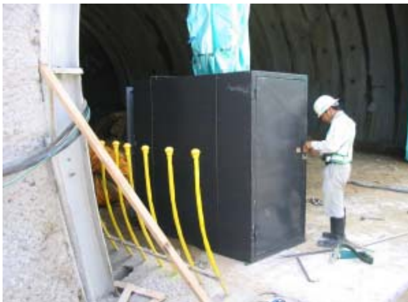
人路box設置
