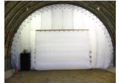
図-1 隔壁バルーン設置状況
