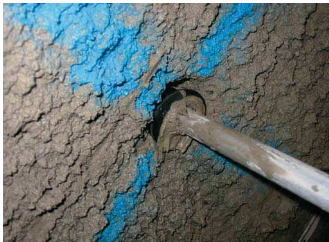
3 モルタル注入中
