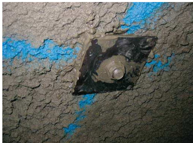
6 ロックボルト挿入終了
