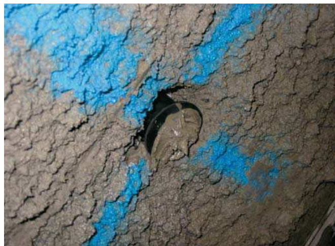
4 モルタル注入終了
