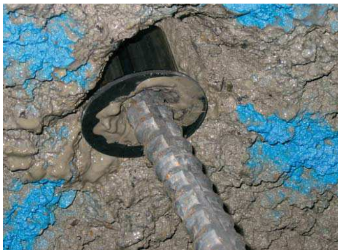
5 ロックボルト挿入中
