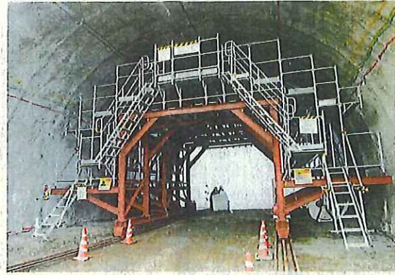
台車使用イメージ(上部がクサビ緊 結式足場「ダーウィン」、下部がH形鋼を用いた 基礎部材、自走装置を備えた駆動部材)
