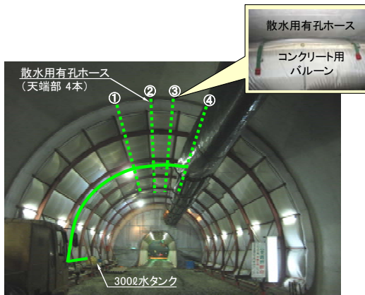
写真-1 散水機能付きコンクリート用バルーン全景
