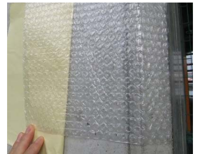
写真1 MTP貼付状況
