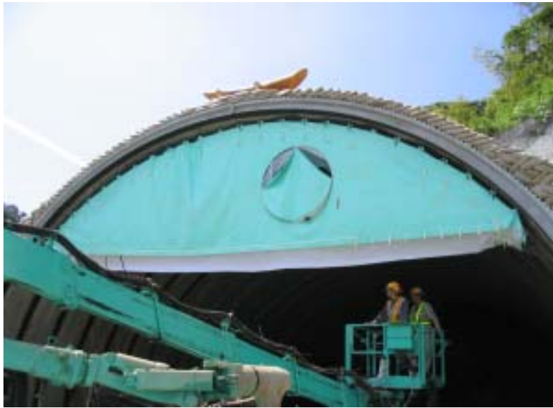
アーチ部取付け完了
