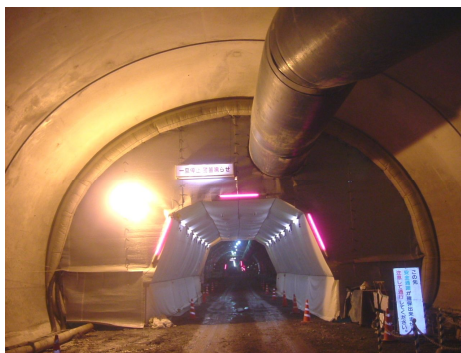
写真1 セントル本体養生
