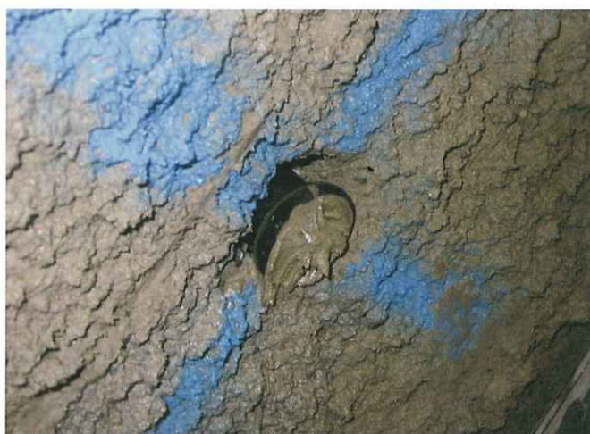
4 モルタル注入終了
