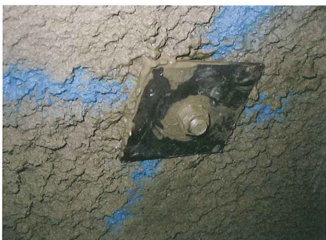
6 ロックボルト挿入終了
