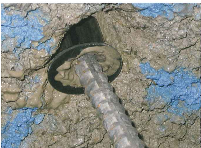
5 ロックボルト挿入中
