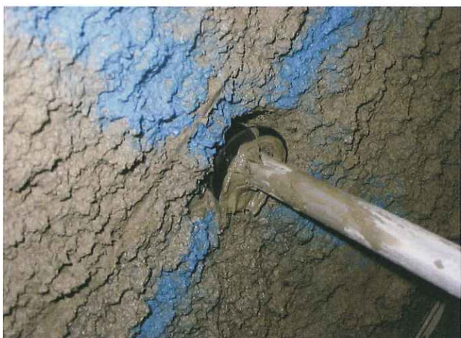
3 モルタル注入中
