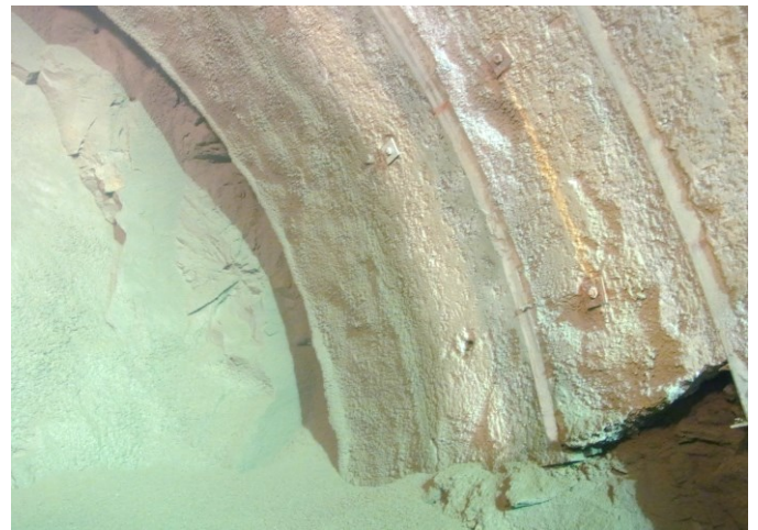
2、吹付け完了(凹凸あり)
