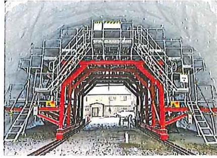
次世代クサビ緊結式足場を利用したトンネル工事向けシート台車の「ダーウィン台車」
