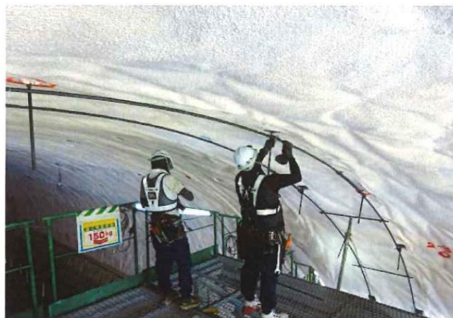
③段取アーチ筋(天)及びKプレート設置
