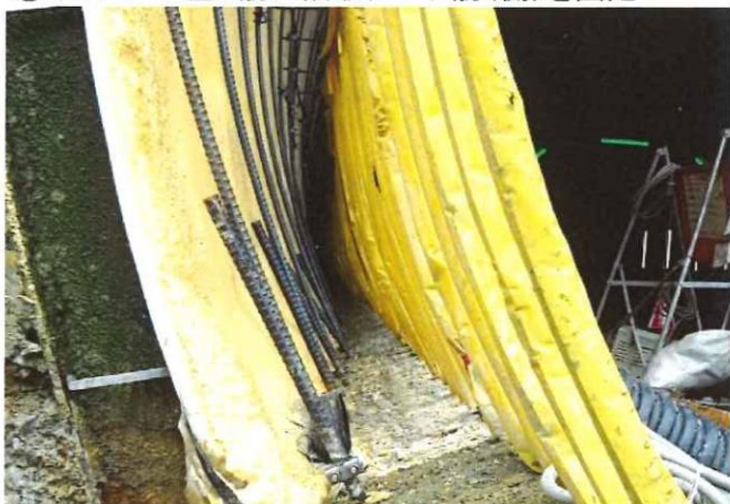
③段取アーチ筋(天)及びKプレート設置
