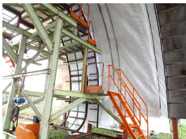
写真-2 展張状況
