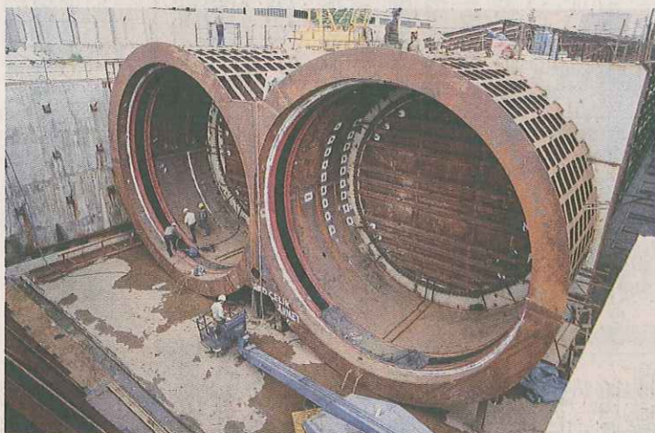
ボスボラス海峡横断鉄道トンネルにおけるTBM(シールド工法)と沈埋函の海底地中接合—技術賞 Iグループ
