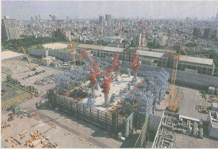
世界最大の平面積を有するニューマチックケーソンの設計施工—東尾久浄化センター主ポンプ棟建設工事—技術賞 Iグループ
