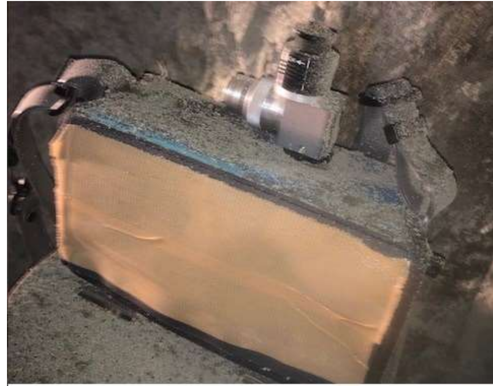
切羽10m程度で吹付を被り、汚れる例
