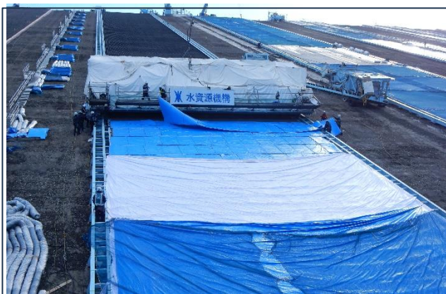
コンクリート打設直後の養生バルーン設置状況
